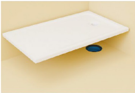
13. Duschtasse auf den Estrich versetzen.
