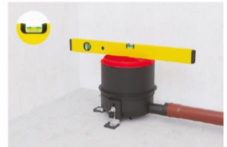
6. Ablaufkörper mit Ablaufleitung verbinden, Rohrgefälle über die Befestigungswinkel in der Höhe einstellen.
