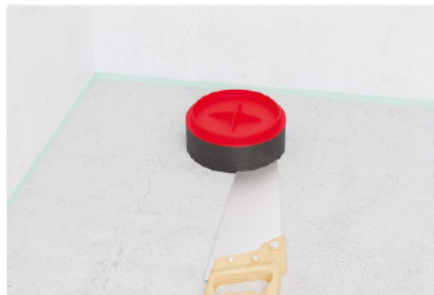
8. Nach dem Aushärten des Estrichs den herausstehenden Rohrstützen estrichbündig mit einer Säge abschneiden.
