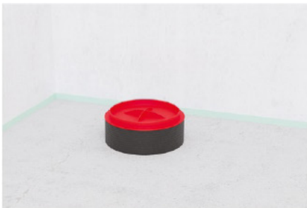
7. Fußbodenaufbau mit Estrich waagrecht herstellen.
