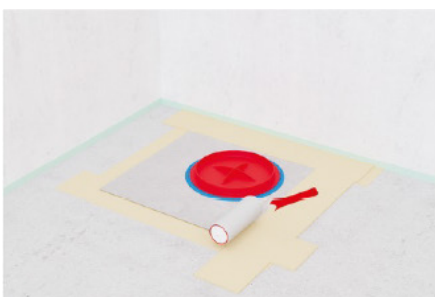
10. Feuchtigkeitsabdichtung unter und ober der Dichtmanschette (Sandwichverfahren), sowie im gesamten Duschbereich auftragen. Alle Anschlussstellen mit bauseitigen Dichtbändern versehen.
