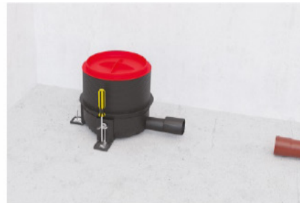
5. Ablaufkörper mittels Befestigungswinkel an die Rohdecke fixieren.
